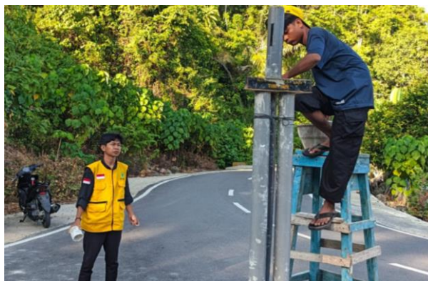
Gambar 3 Proses pemasangan dan penyelesaian bagian tugu penanda arah..
