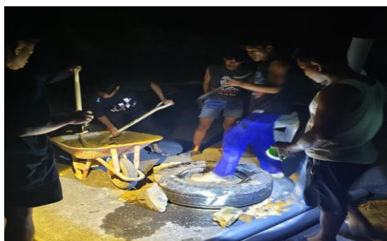
Gambar 1. Proses pencampuran bahan konstruksi untuk pembangunan tugu penanda arah.
