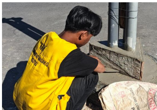
Gambar 2. Pengerjaan bagian dasar tugu pada lokasi yang telah ditentukan.
